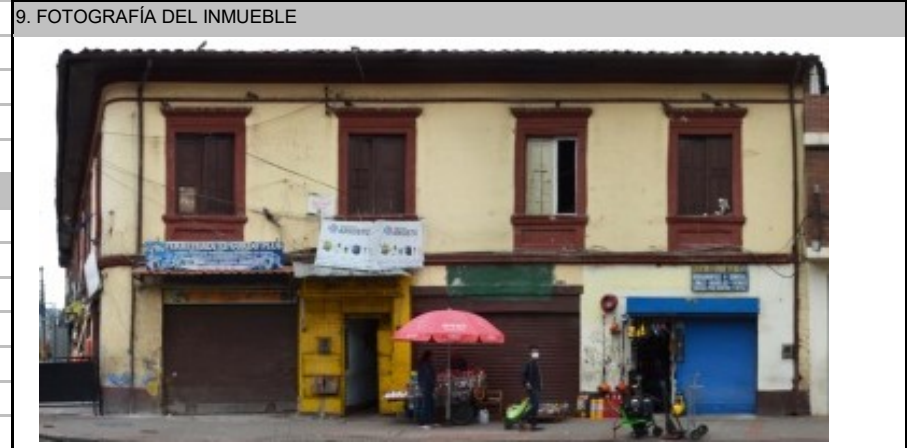
Fuente: Equipo Fotografía PEMP Patrimonio Inmueble
